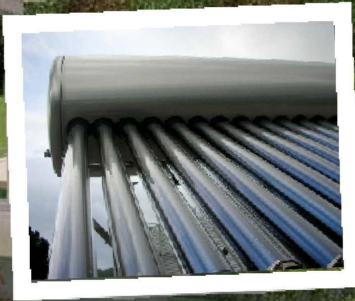
collettore termico a tubi sottovuoto
