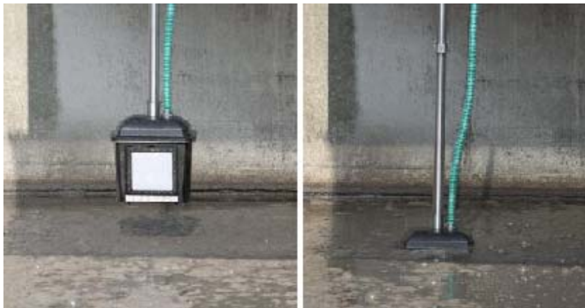
Elemento filtrante direttamente in vasca
